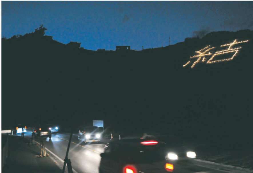
2006年の土砂崩れから復旧し、結の電飾文字で飾られた県道35号の斜面＝27日、中城村
